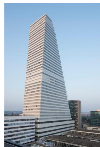
Hauptsitz von Roche in Basel – Blick auf Bau 1
